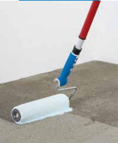
Alapozó felhordása az aljzatra
