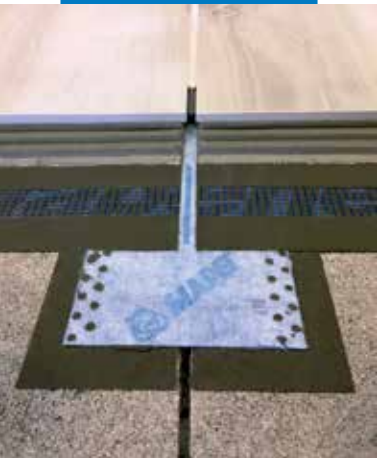
Mapeband Easy elhelyezése esztrich dilatáció fölé
