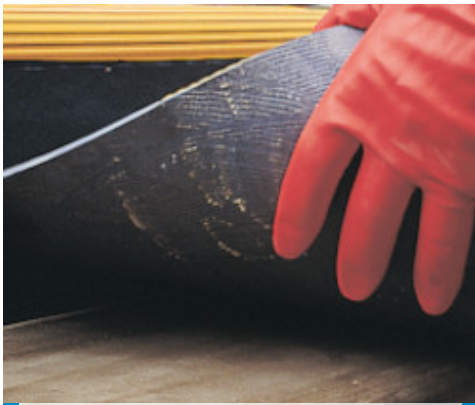
Montarea imbracamintilor din cauciuc pe scari cu Adesilex LP
