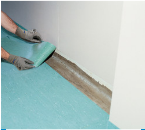
Montarea benzilor de colt din PVCA
