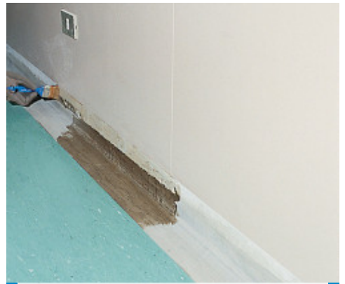
Lipirea profilelor din PVC Liuni PVC cu Adesilex LP
