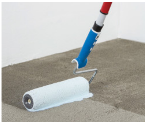
Aplikácia penetračného náteru na podklad
