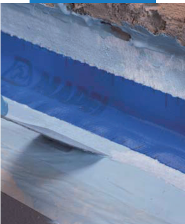
Mapelastic® AquaDefense nanášaný na pogumovaný pás Mapeband v mieste styku stena/podlaha
