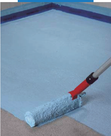
Mapelastic® AquaDefense nanášaný valčekom v prvej vrstve na cementový poter
