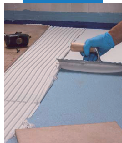
Lepenie dlažby na Mapelastic® AquaDefense
