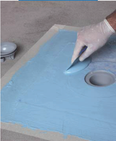
Nanesenie membrány proti vode Mapelastic® AquaDefense v mieste priepuste Drain Vertikal
