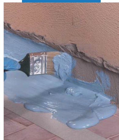
Mapelastic® AquaDefense nanášaný štetcom v mieste styku stena/podlaha pred inštaláciou pásiky Mapeband
