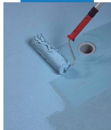
Mapelastic® AquaDefense nanášaný valčekom v druhej vrstve
