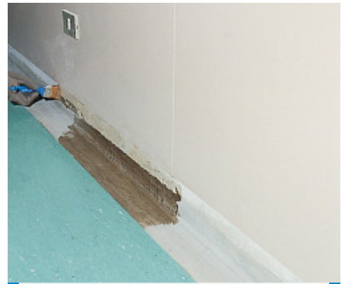
Inštalácia Liuny PVC krytiny s použitím Adesilex LP
