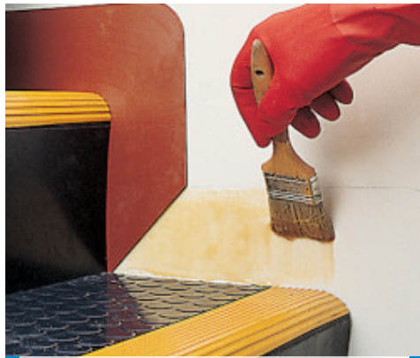
Inštalácia gumenej soklovej lišty s použitím Adesilex LP
